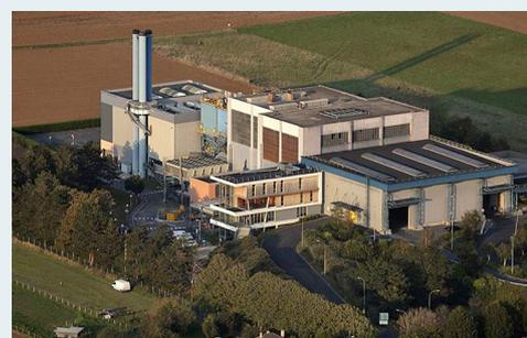
↳ L'incinérateur de Colombelles transforme dans ses fours à haute température (1 200°C) les déchets non recyclables en énergie.
