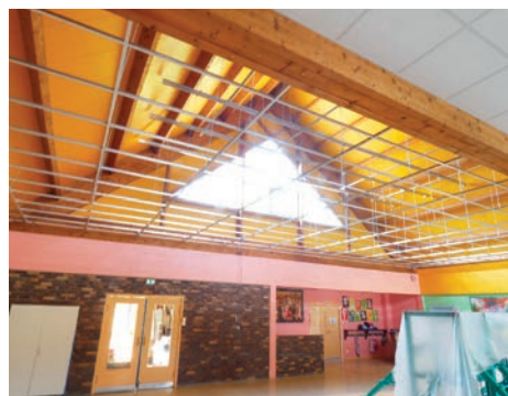
Installation de faux plafonds dans le hall de l'école de Creully (creully-sur-Seulles) pendant travaux à gauche et après à droite
