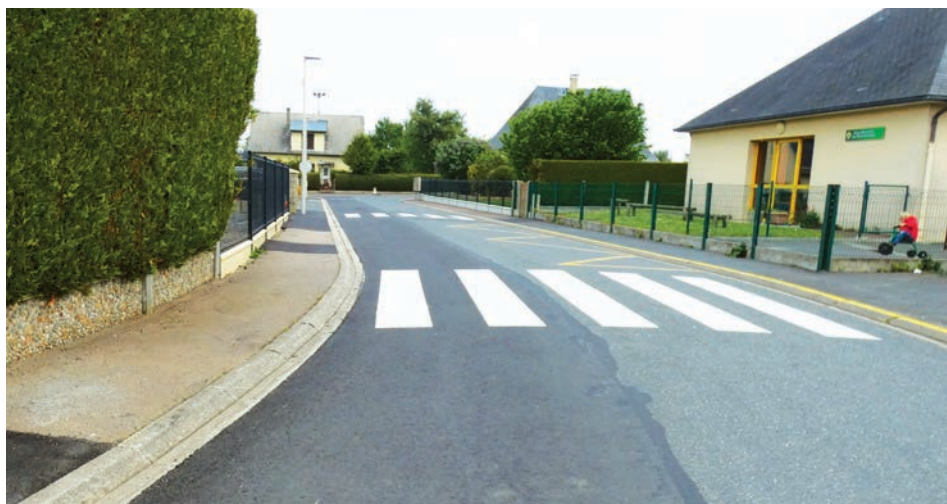
Travaux achevés à Fontenay-le-Pesnel
