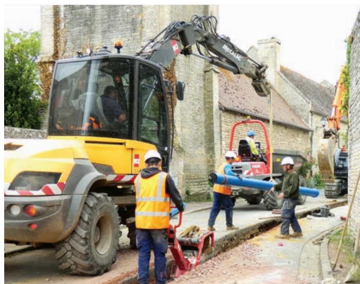
Sécurisation du réseau à Saint-Gabriel-Brécy (Creully-sur-Seulles)
