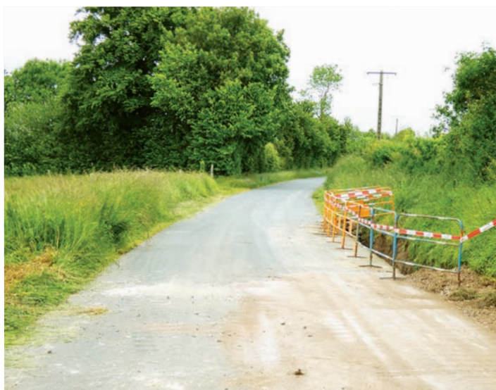
Travaux en cours à Rucqueville (Moulins-en-Bessin)
