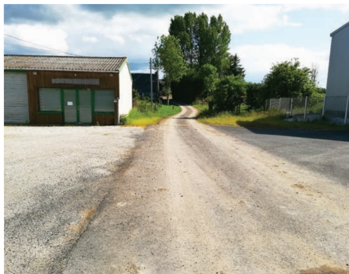
Programme 2018 - Travaux de voirie achevés à Lingèvres
