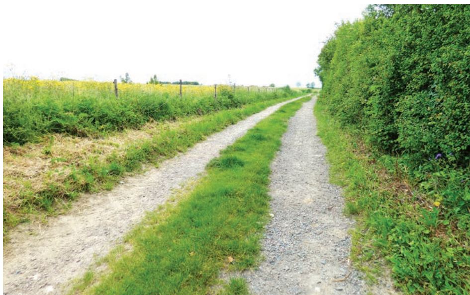
Travaux de réfection du chemin entre Villiers-le-Sec (Creully-sur-Seulles) et Bazenville prévu courant 2019
