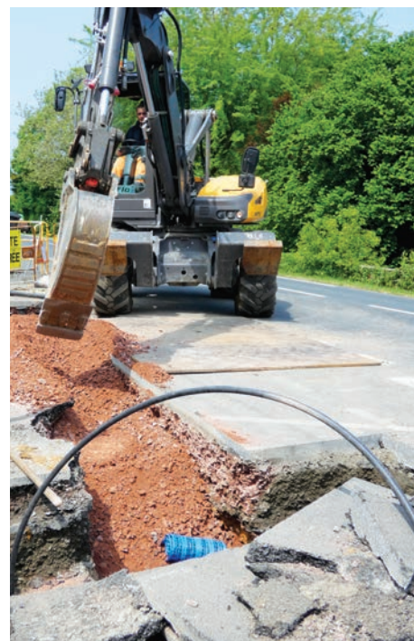
Travaux de renouvellement à Bucéels
