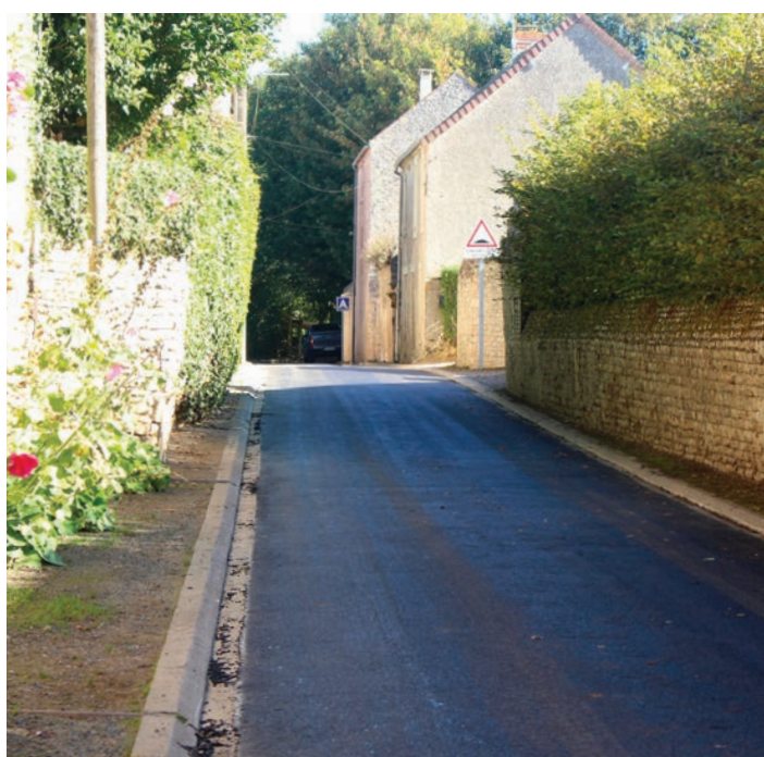
Programme 2018 - Travaux de voirie achevés à Sainte-Croix-sur-Mer
