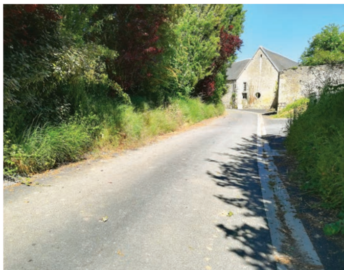
Programme 2018 - Travaux de voirie achevés à Ducy-Sainte-Marguerite
