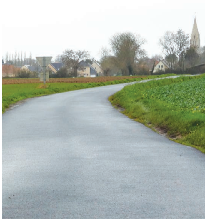
Programme 2018 - Travaux de voirie achevés à Bény-sur-Mer
