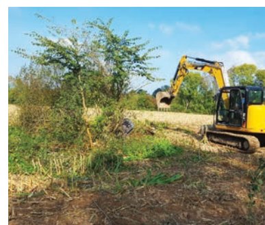
Des travaux de restauration seront également prévus à Juvigny-sur-Seulles
