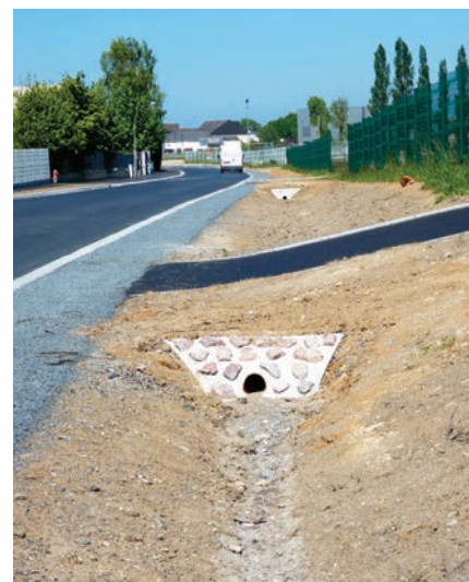
Accotement de la zone d'activités réalisé par STM
