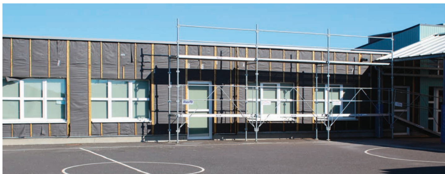
Travaux école de Lantheuil (Ponts-sur-Seulles)
