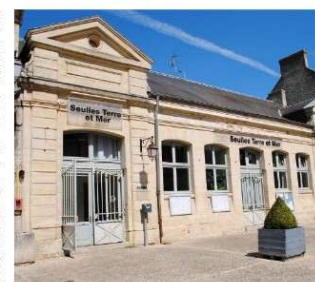
Siège de l'intercommunalité de Seules Terre-et-Mer à Creully-sur-Seulles. D. BOUET
